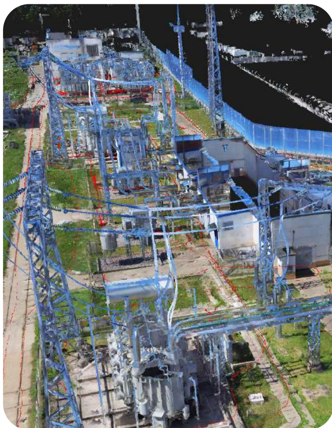
Сканирование электрической подстанции
