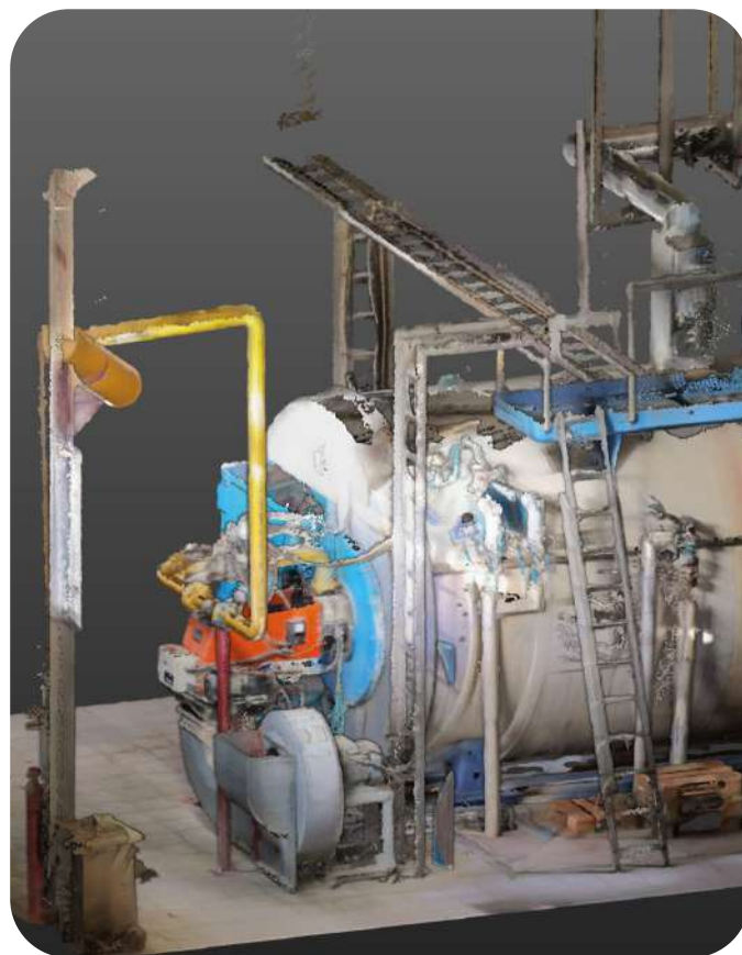
Сканирование насосной станции
