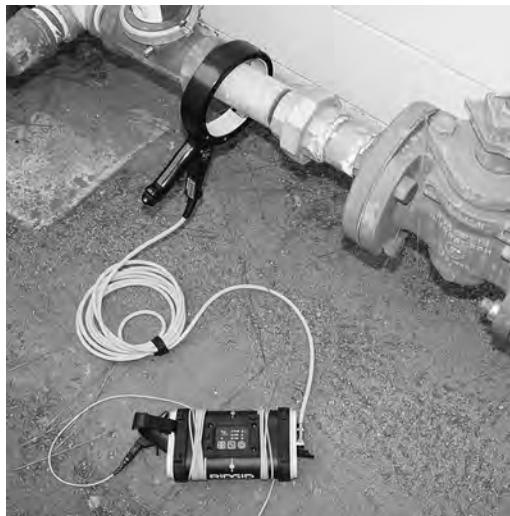
Рис. 9: Индукционный зажим присоединен к проводнику
