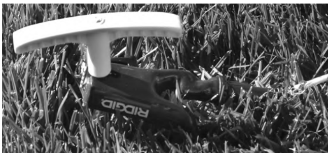
Рис. 7 – присоединение провода к заземляющему штырю
