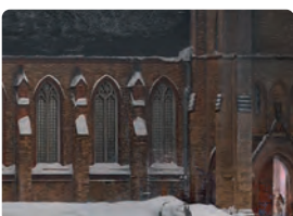
Архитектурные обмеры и обследования
